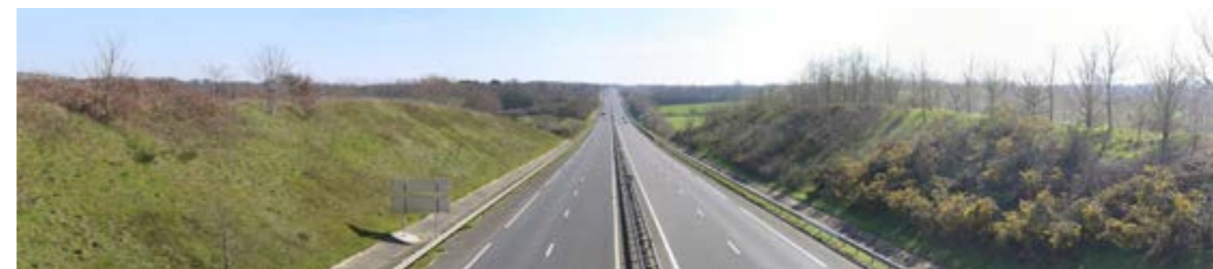
Photo 84 : Les talus encadrant la RN249 ferment les vues vers le grand paysage (Source : AEPE-Gingko, le 21/03/2019)
